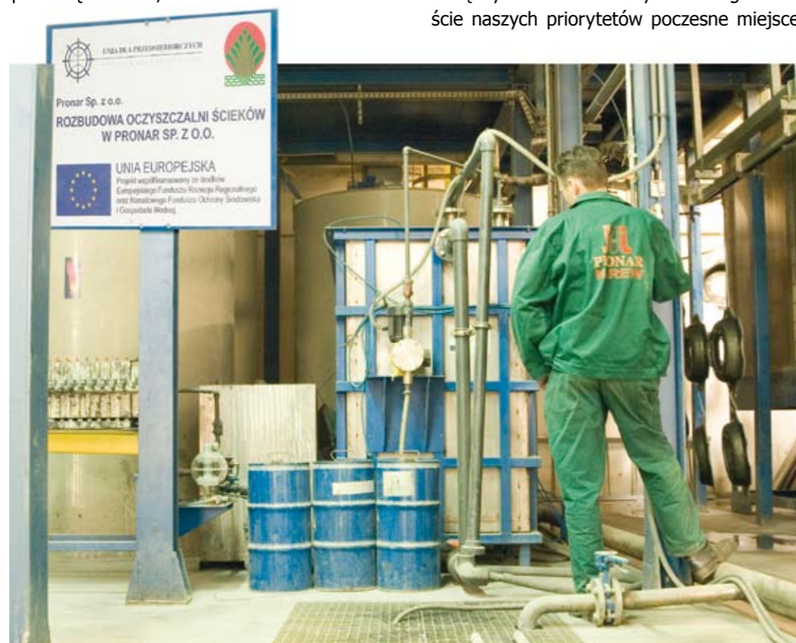
Podczyszczalnia ścieków technologicznych przy malarni katalforetycznej
